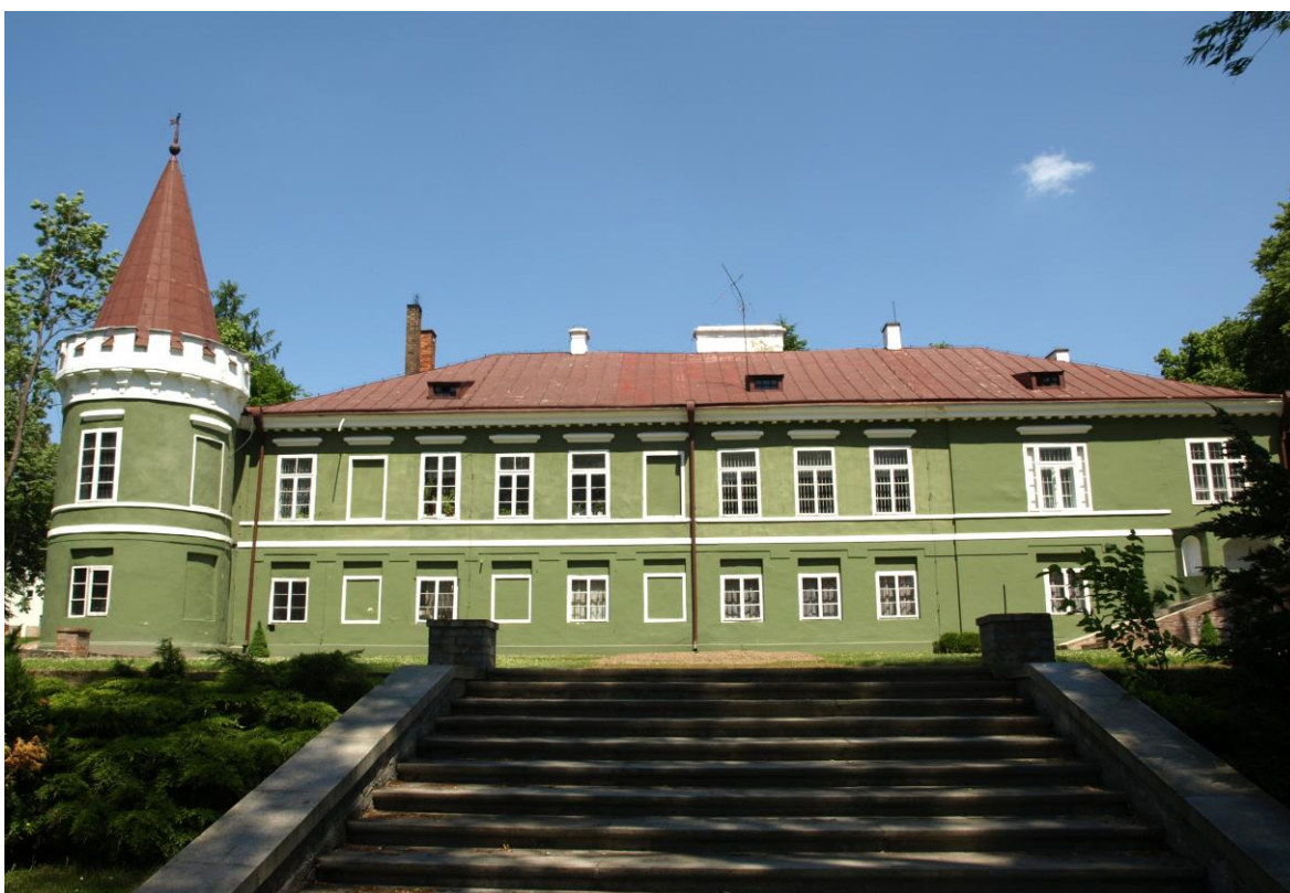
Pałac w Tarnogórze, Fot. G. Suchodolski
