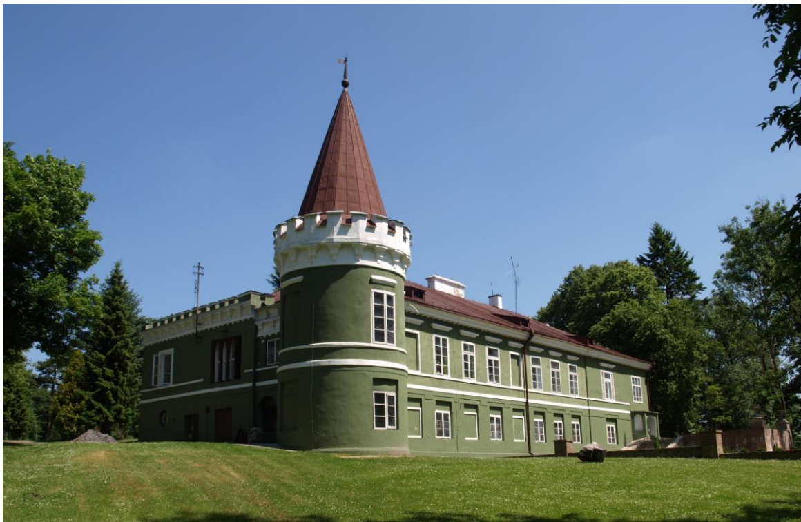
Pałac w Tarnogórze Fot. G. Suchodolski
